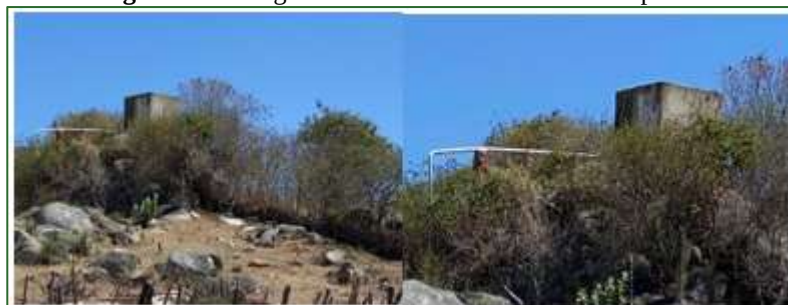
Figura 03 - Imagem ilustrativa do reservatório suspenso.
